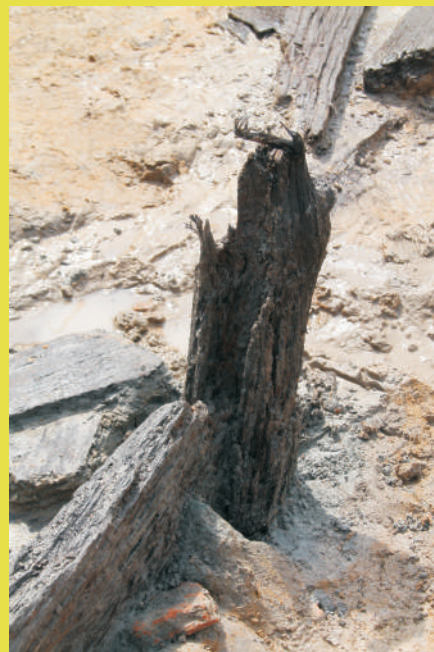
Dettaglio di un incastro delle paratie del canale
